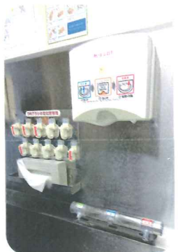
2階の両端はケーキ室とクッキー室になっています。それぞれの作業室の前室には、泡状の石鹼・水・消毒液が自動で出てくる手洗い場があり、
